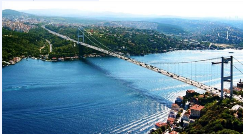
Figura 4. Lo stretto del Bosforo è attraversato da due ponti, il più recente, il Fatih Sultan Mehmet Bridge, è un ponte sospeso a 4 corsie con piloni di acciaio, la cui campata principale misura 1.090 m.
